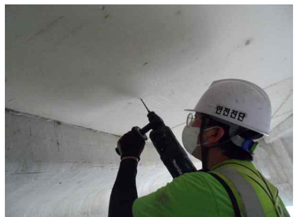
탄산화깊이 측정 현황
